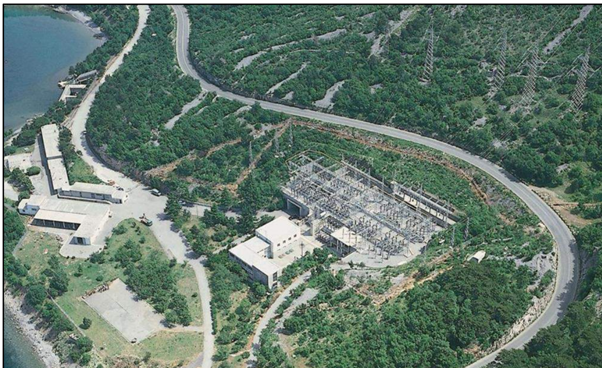
Slika 2.1.-4. Rasklopište i ulaz u strojarnicu HE Senj
